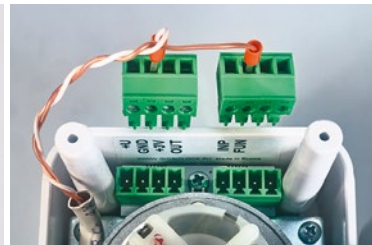
Фото 23. Подключение проводного выключателя
