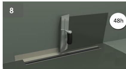
Нанесите второй слой гидроизоляционного поверхностного герметика.
