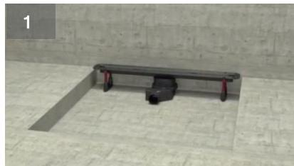
Установите конструкцию трапа на пол ванной комнаты в выбранное для него место и зафиксируйте путем крепления ножек в пол (используйте крепеж, входящий в комплект).
