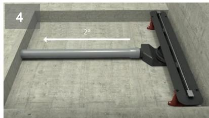
Присоедините канализационную трубу к выходу трапа с уклоном не менее 2 градусов от трапа.
