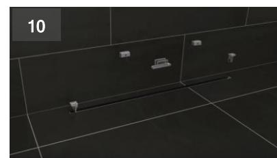
Завершите монтаж трапа: установите сетку для улавливания мелкого мусора и дизайн-вставку Slim, закрепите детали крепежом, входящим в комплект.
